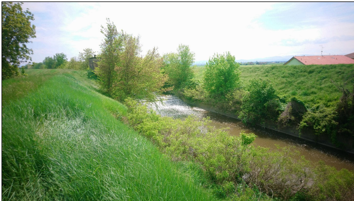
Figura 2.4 la sponda destra del rilevato arginale in dissesto vista da valle, si nota la differente vegetazione in corrispondenza del movimento franoso
